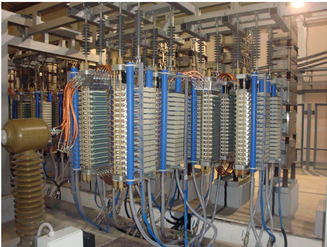
Подвесные транзисторные модули вставки постоянного тока на преобразователях напряжения СТАТКОМ на ПС 220 кВ «Могоча»
