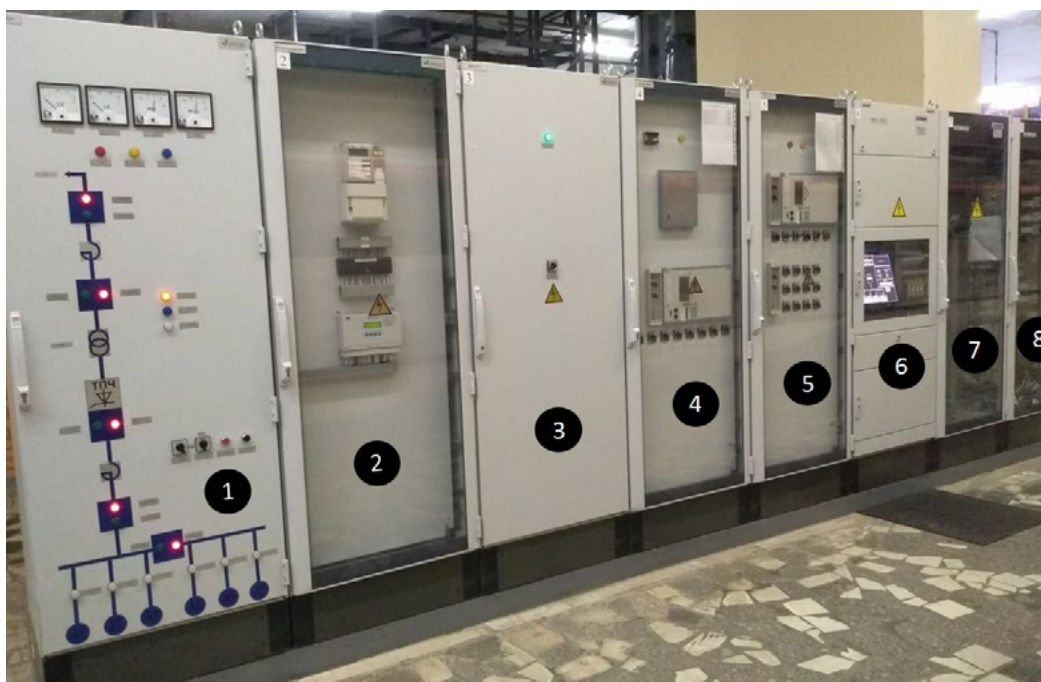
Силовые шкафы преобразователя частоты и системы автоматики управления пуском — остановом обратимых гидроагрегатов Загорской ГАЭС
